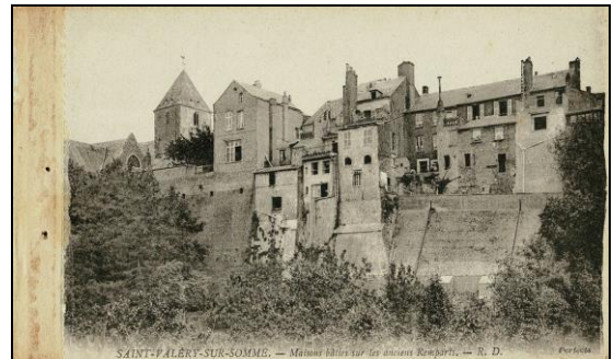
SAINT-VALÉRY-SUR-SOMME. - Maisons bâties sur les anciens Remparts. - R. D. 4 ème carte du carnet
