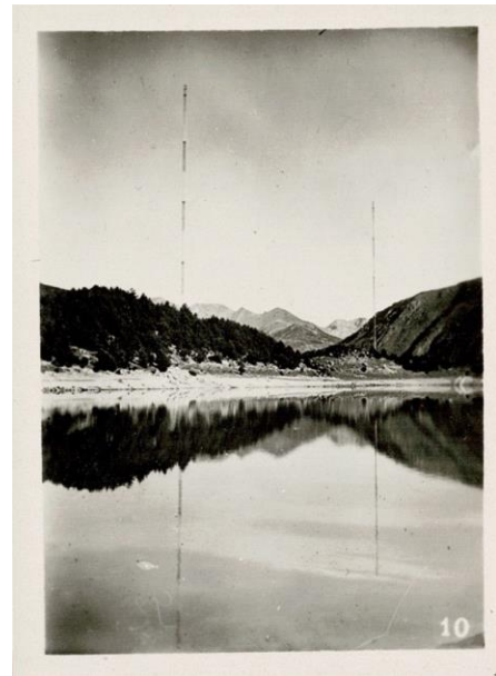
10 Lac d'Engolasters, Antennes de Radio Andorre
