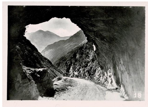
18 Sortie du Tunnel - Route de la Massana
